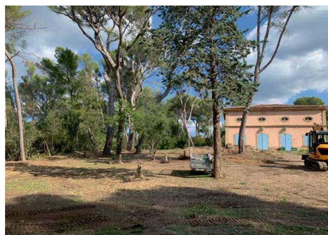
Vue d'une partie du terrain nettoyé à l'aide des machines de la gamme électrique E-Tech de JCB sur cette propriété de près de 1 ha.
