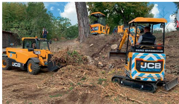
Sur la route en contrebas du chantier, le télescopique électrique JCB 525-60E récupère dans son godet le broyat rassemblé par la minipelle.
