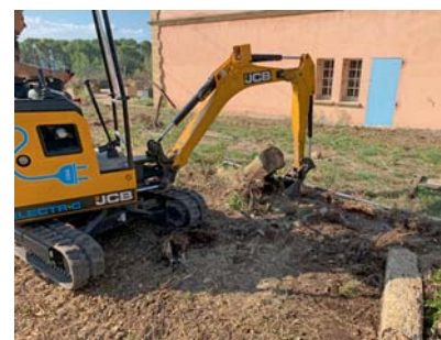
La minipelle 19C-1E permet une grande diversité de travaux comme cet arrachage de lourds soubassements en pierre.
